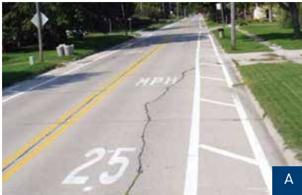
รูปแบบการตีเส้นเพื่อลดขนาดช่องจราจร (A) บริเวณไหล่ทาง (B) บริเวณเส้นแบ่งทิศทางการจราจร
