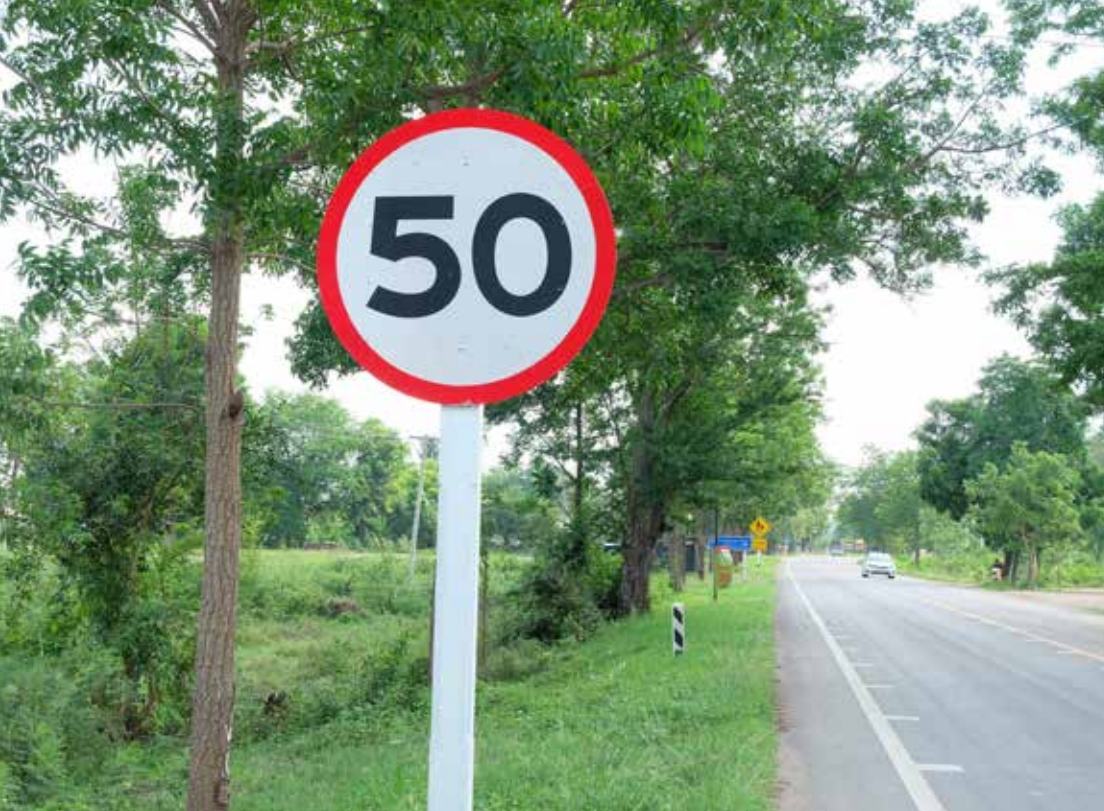
ตัวอย่างการติดตั้งป้ายความเร็วจำกัดเฉพาะที่
