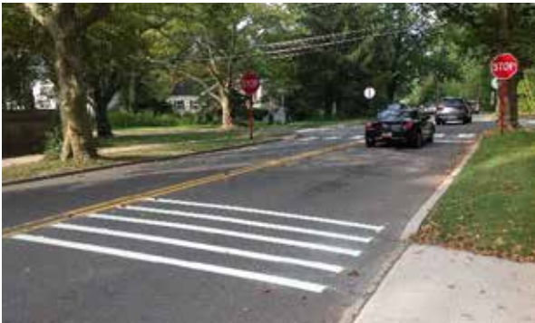
แถบชะลอความเร็วตามแนวขวางแบบเต็มช่องทางจราจร
