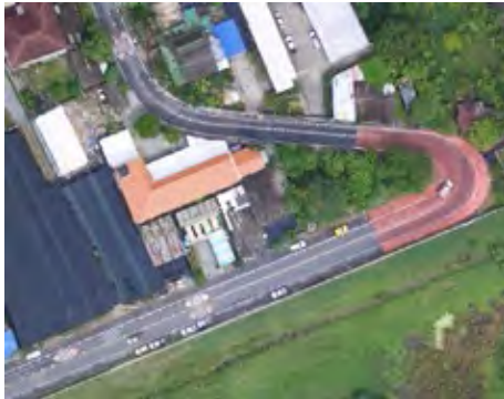
รูปที่ 31 สภาพถนนหลังการปรับปรุง
