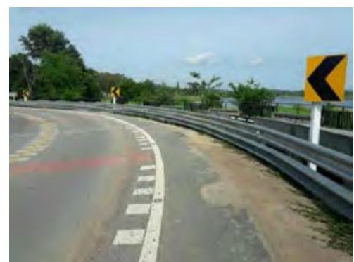
รูปที่ 34 สภาพหลังการปรับปรุง น.ม.3052 กม.18+200
