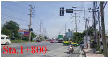
รูปที่ 25 ภาพภาพถ่ายทาง สป.2001 กม.1+800
