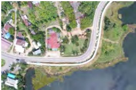
รูปที่ 32 ภาพสายทาง น.ม.3052 กม.18+200
