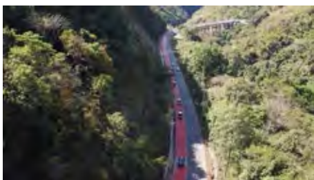
รูปที่ 12 การใช้พื้นที่แถบบริเวณสะพานห้วยตอง
