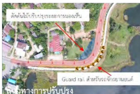
รูปที่ 33 สภาพหลังการปรับปรุง น.ม.3052 กม.18+200
