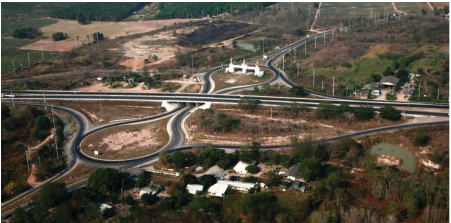
รูปที่ 13 ทางลอดบนทางหลวงหมายเลข 4
